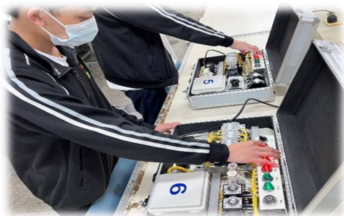
工業配線丙級實作
